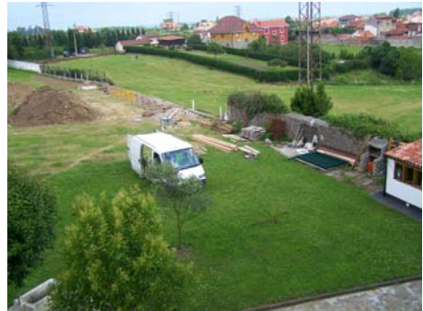
Obra de rehabilitación del muro del Centro de Miranda (Avilés) financiado por la Obra Social de La Caixa
